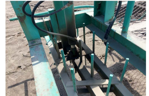
後方爪ハローの昇降用油圧シリンダーの油漏れあり
