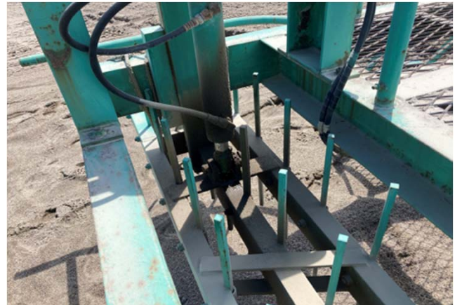
後方爪ハローの昇降用油圧シリンダーの油漏れあり
