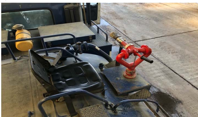
⑨タンク上部 放水銃装備
