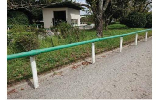
②使用状況遠景です。支柱直径は9cmで、地面に穴をあけ、地中に70cmほど埋め込んだ状態です。
