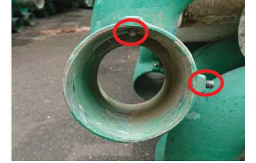
④笠木は支柱付属の六角穴付ボルト2か所で固定します。ただし、ボルトが突き出た状態で固まっているもの(笠木を通すため、ボルトの切断が必要)や、ボルトが回らなくなっているもの(笠木を固定するため、新たに別の個所に穴をあけてボルトの打ち込みが必要)が半数程度あります。
