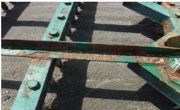
○フレーム部拡大 鉄部全体に腐食あり
