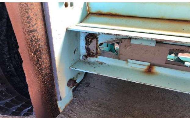
○泥除けプレート腐食激しい
